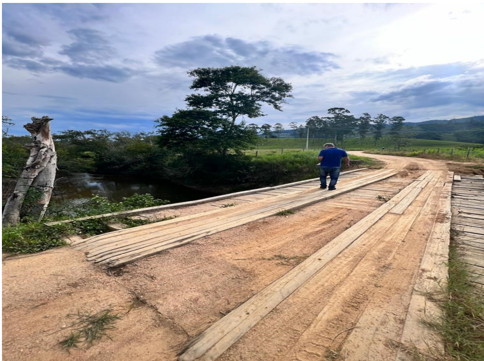
Foto 02- Pontilhão de madeira
