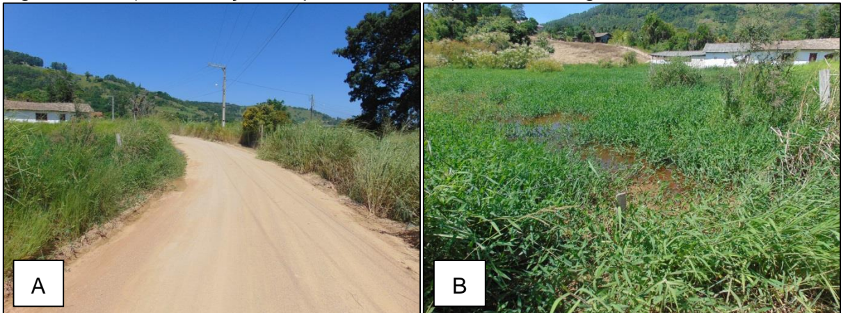
Figura 52 – A) Localização do ponto crítico. B) Macrodrenagem assoreada.
