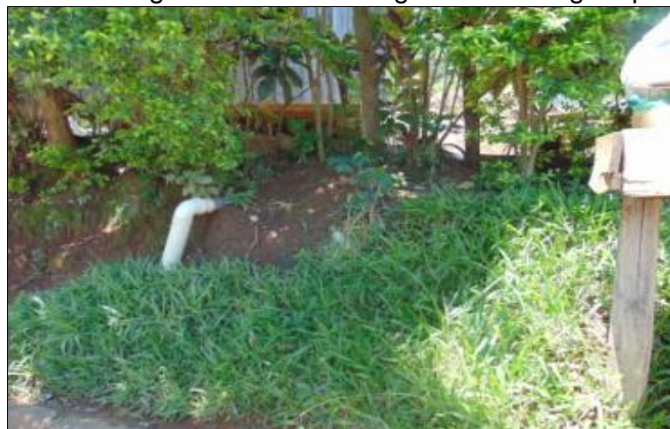
Figura 61 – Tubo de PVC ligando à rede de esgoto na drenagem pluvial.
