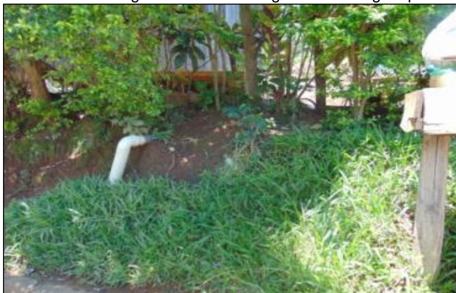
Figura 102 – Tubo de PVC ligando à rede de esgoto na drenagem pluvial.
