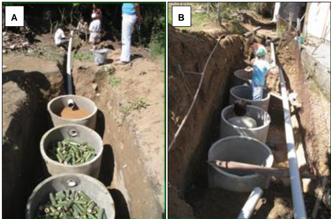
Figura 106 - Construção do Sistema Tratamento de Esgoto nas Comunidades Rurais.
