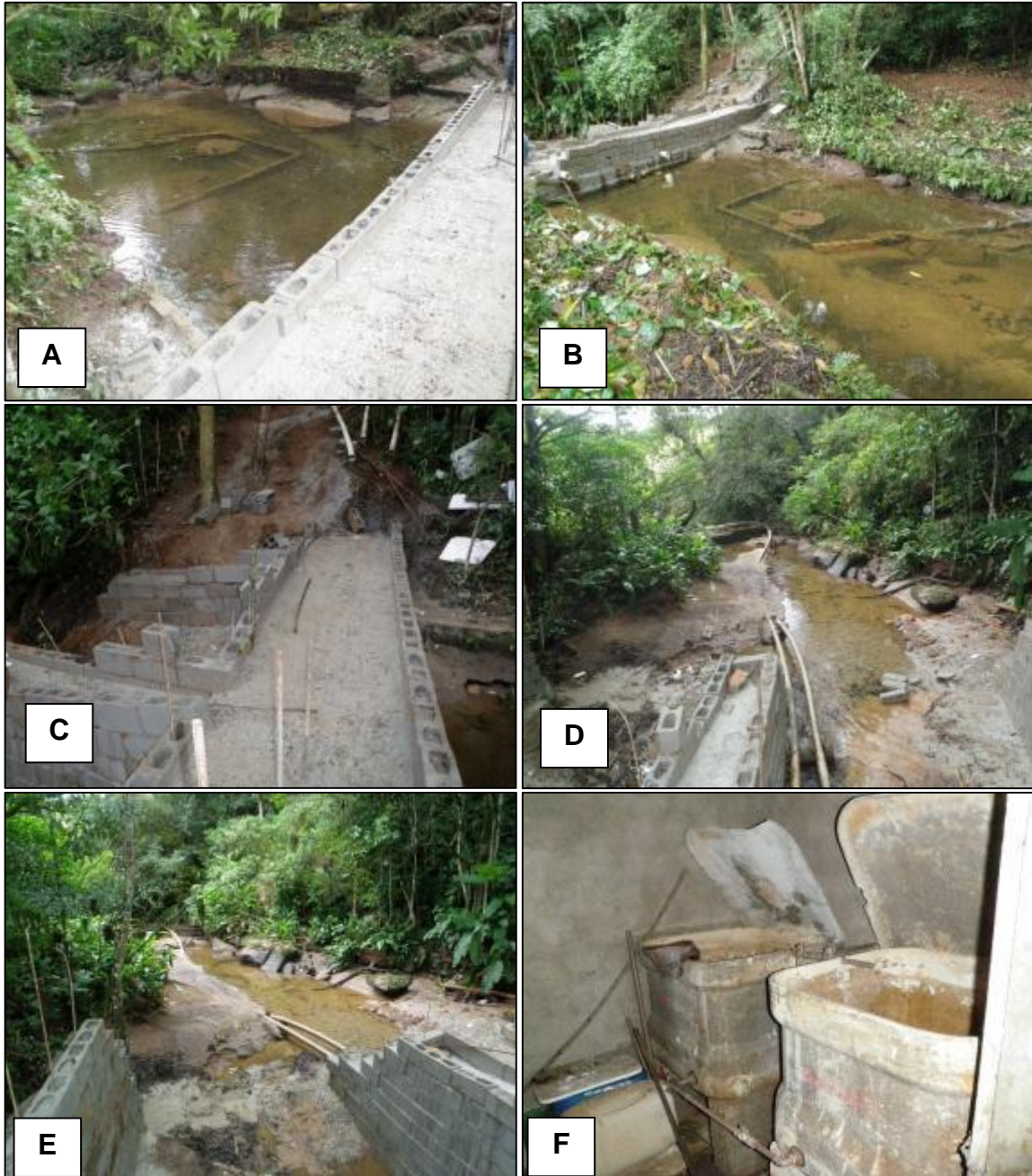
Figura 4 – A, B e C) Sistema de barramento construído no córrego do Tombo D'Água, D e E) Detalhes de tubulações de adução água bruta. F) Antiga casa de cloração atualmente desativada.
